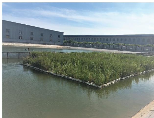
图1 生态浮床养殖池塘尾水处理系统
